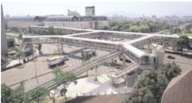
商工センターペDESTリアンデッキ(広島市) 網箱桁橋
