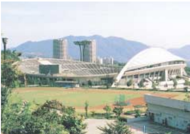
造成地盤調査(広島広域公園)
