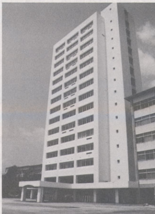
完成した新1号館
